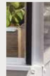
Höhere Windstabilität bietet die Verglasung mit Verglasungsleisten, die die Kanten auf ganzer Länge an das Profil klemmen. Ähnliche Stabilität erhalten die Gewächshäuser mit Federklammern durch den Einsatz einer Windsicherung (s. S. 46).
